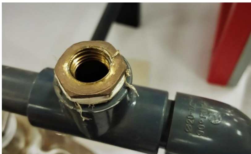
شکل (۳) - محل اتصال فشارسنج
